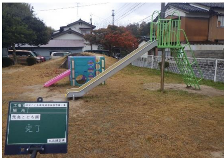
認定こども園荒島遊具改修後
