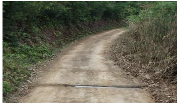
整備後の作業道
