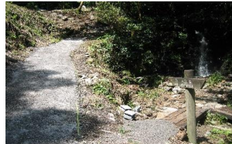
ふれあい広場「不動滝」整備
