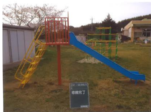
島田こども園遊具修繕後
