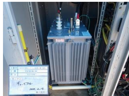
伯太中学校エアコン設置工事後（電気）
