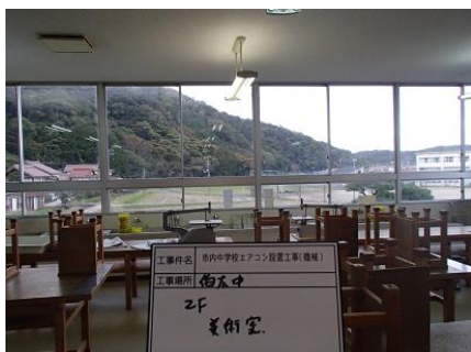
伯太中学校エアコン設置工事前（機械）
