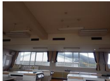
飯梨小学校エアコン設置工事後（機械）
