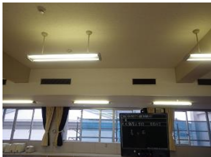
飯梨小学校エアコン設置工事前（機械）
