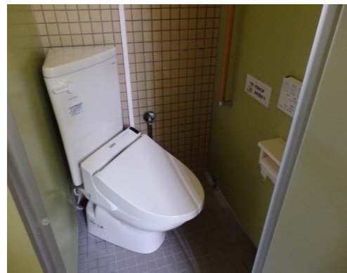
東比田交流センタートイレ改修工事
