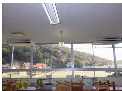
伯太中学校エアコン設置工事後（機械）
