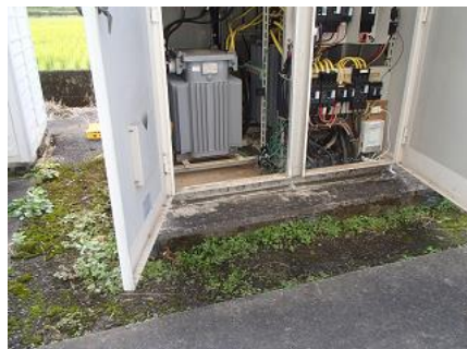
伯太中学校エアコン設置工事前（電気）
