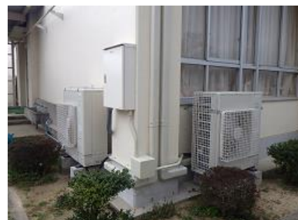
能義小学校エアコン設置工事後（機械・電気）
