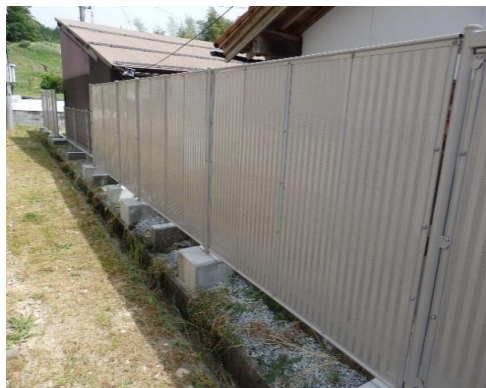
比田交流センターブロック塀撤去・改修工事
