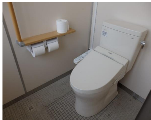
宇波交流センタートイレ改修工事
