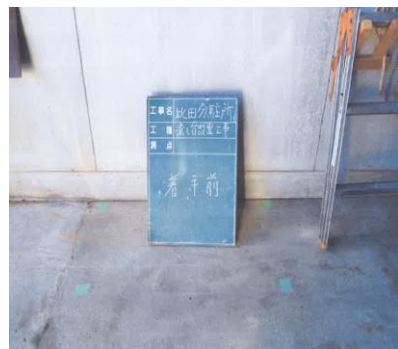
比田分駐所流し台設置工事
