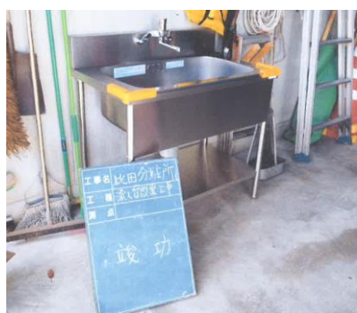
比田分駐所流し台設置工事
