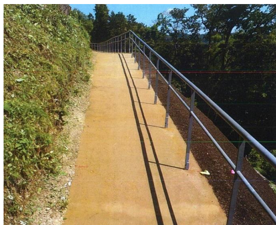
災害復旧完成状況（三ノ丸園路）
