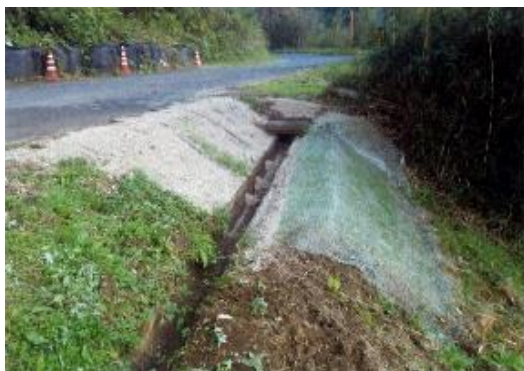
鳴滝水路災害応急工事
