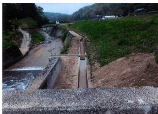
下小竹本郷水路災害応急工事
