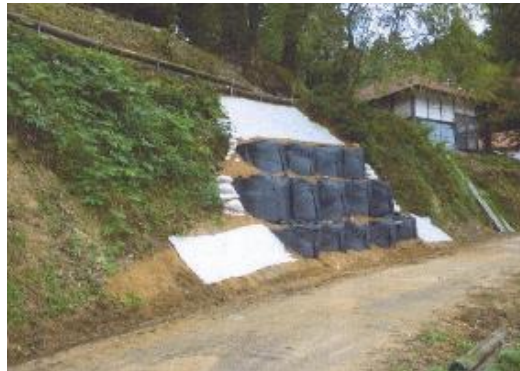
西谷本郷農道災害応急工事
