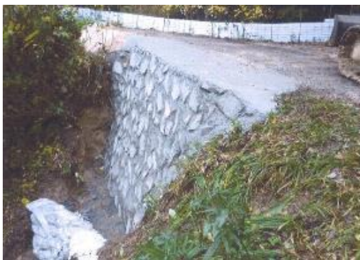
永江農道災害応急工事
