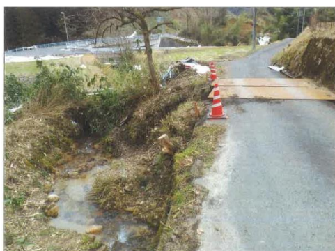
駒場線道路災害復旧工事 着工前
