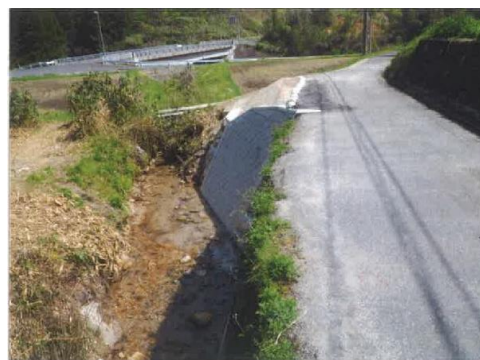
駒場線道路災害復旧工事 完成
