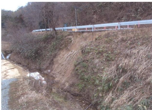
補助災害 布部山佐線道路災害復旧工事 着工前
