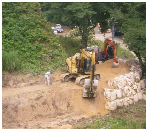
仮設道路撤去工事（山中御殿）
