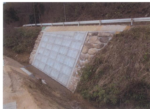
補助災害 布部山佐線道路災害復旧工事 完成
