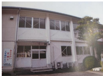
下山佐交流センター耐震改修工事完了後
