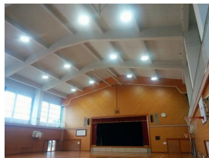
宇賀荘小学校吊天井改修工事後
