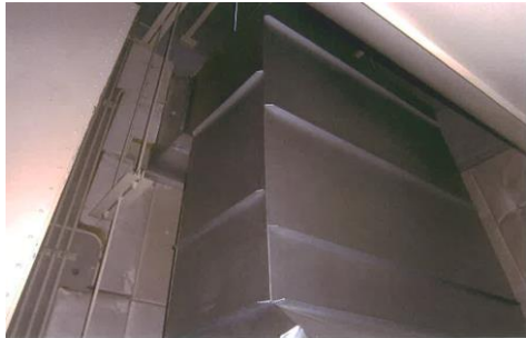
第二中学校防火ダンパー取替工事
