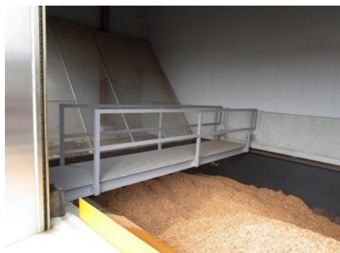
サイロ内通路足場設置
