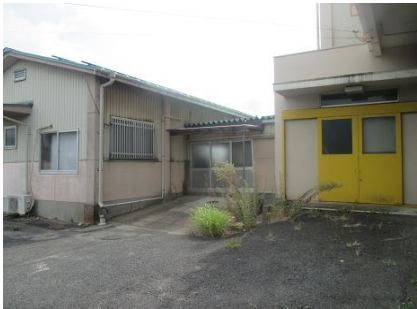
赤江小学校給食配膳室施工前
