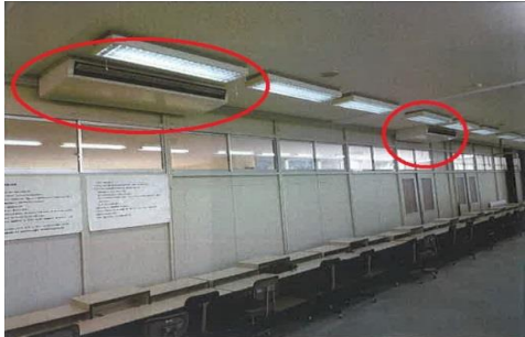
伯太中学校PC教室エアコン設置工事後
