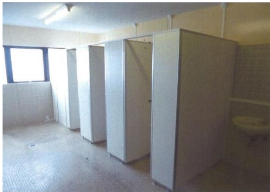
2階一般男子便所トイレブース
