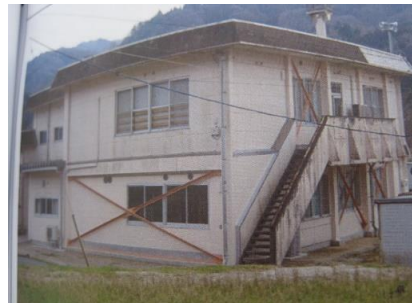
比田交流センター耐震改修工事完了後
