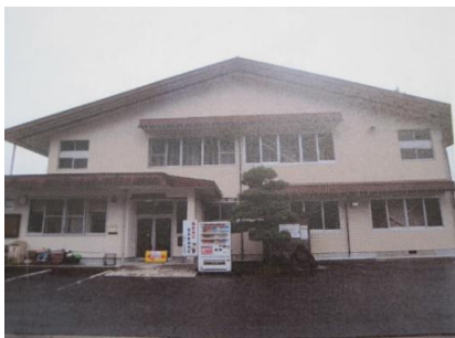
安田交流センター耐震改修工事完了後
