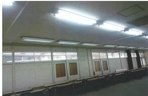
伯太中学校PC教室エアコン設置工事前
