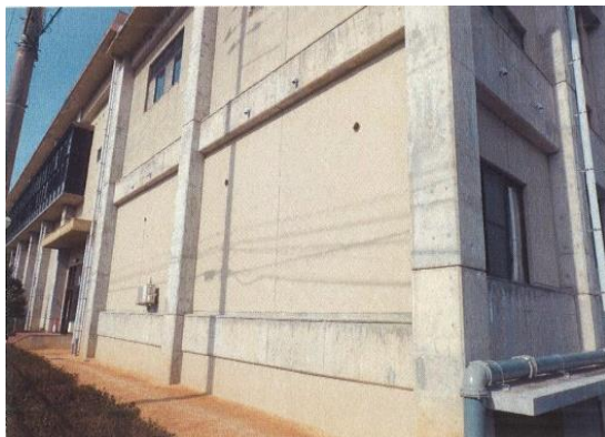
小体育館耐震壁増設
