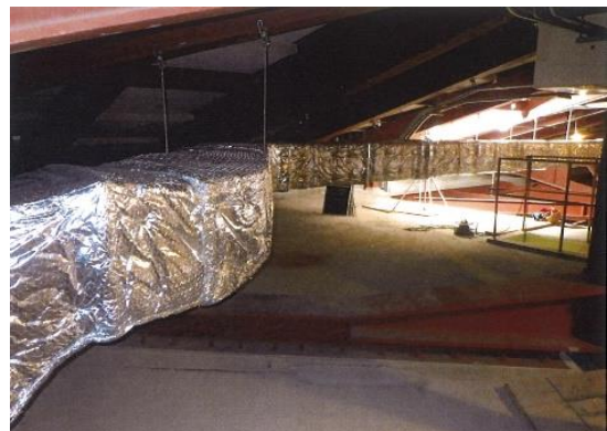
機械設備のダクト保温
