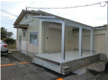
赤江小学校給食配膳室施工後
