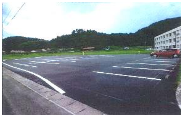
伯太体育館駐車場整備工事
