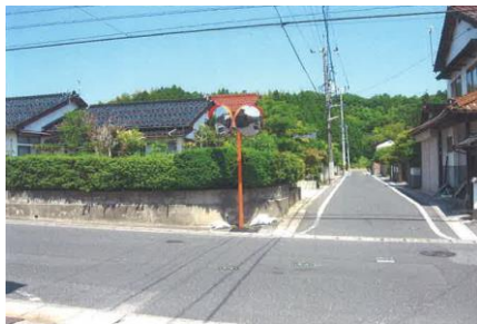
カーブミラー新設（神塚町地内）
