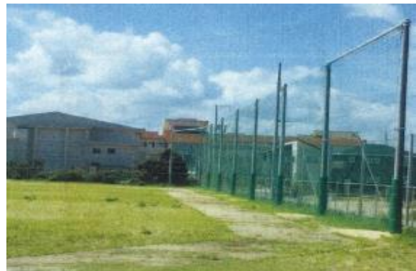
安来球場防球ネット改修工事
