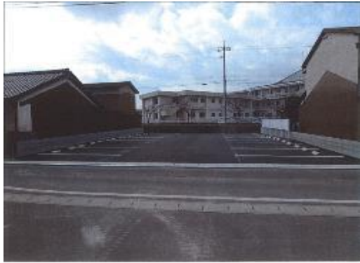
安来市民体育館駐車場整備工事
