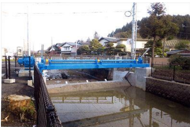
掛岩水門製作・据付工事 竣工
