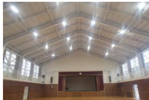
伯太中学校吊天井改修工事施工後
