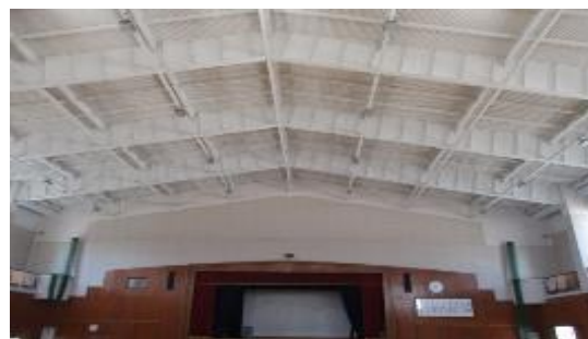
第一中学校吊天井改修工事施工後
