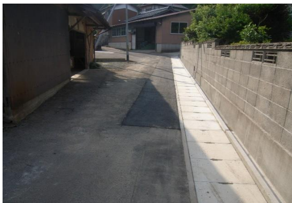
日白下水路改良工事 竣工写真
