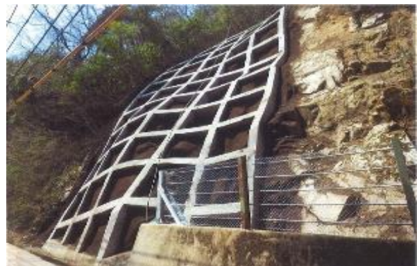
補助災害 安平線道路災害復旧工事 竣工写真
