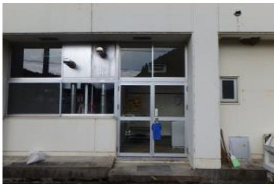
伯太中学校給食配膳室施工前
