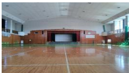
第一中学校吊天井改修工事施工前
