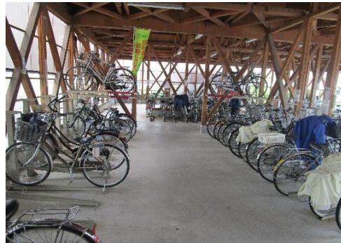
荒島駅前自転車駐車場
