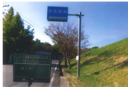
道路標識修繕（広瀬町富田地内）
