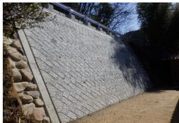
補助災害 下金原線道路災害復旧工事 竣工写真
