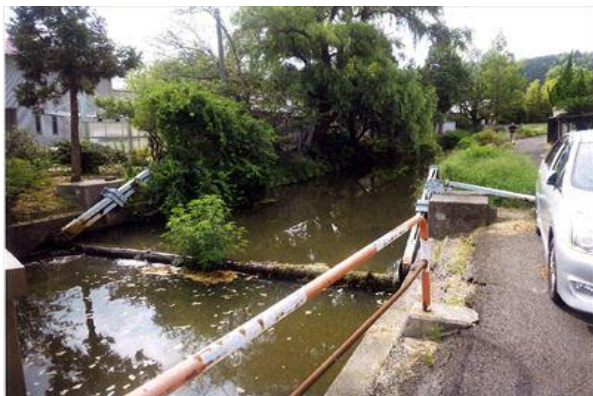
掛岩水門製作・据付工事 着工前
