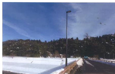
道路照明灯修繕（広瀬町富田地内）
