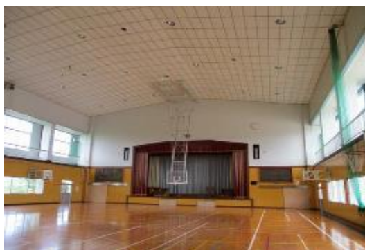
赤江小学校吊天井改修工事施工前
