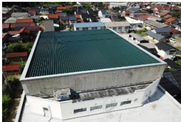
広瀬中央交流センター屋根塗装工事
