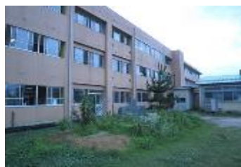
社日小学校給食配膳室施工前
