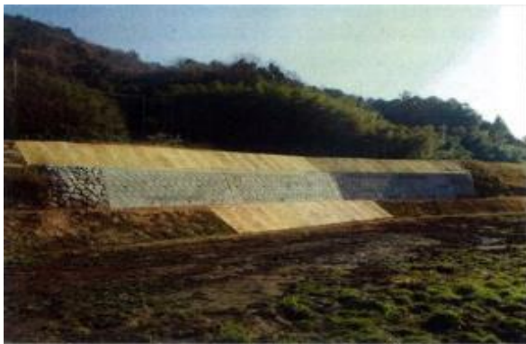
平成29年災1/72才ヶ原上農地災害復旧工事
