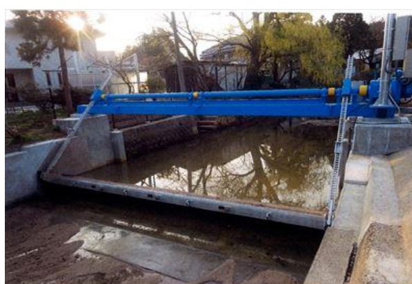
掛岩水門製作・据付工事 竣工
