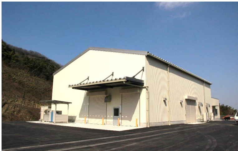
貸工場(下山佐工場) 外観
