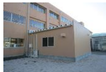
社日小学校給食配膳室施工後
