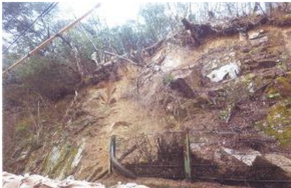
補助災害 安平線道路災害復旧工事 着手前写真
