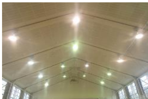
伯太中学校吊天井改修工事施工前
