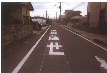
区画線新設（宮内町地内）
