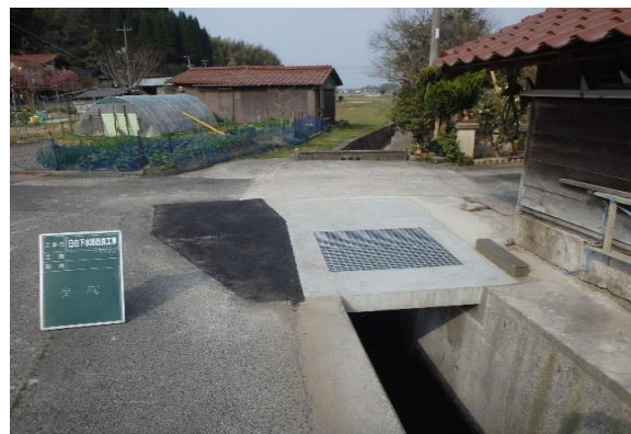
日白下水路改良工事(その2) 竣工写真
