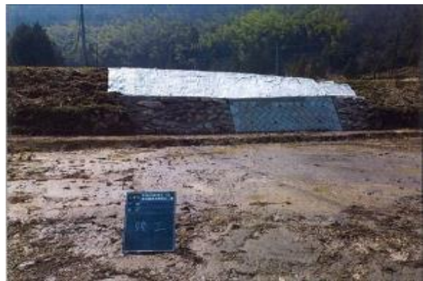
平成29年災4/72新田農地災害復旧工事
