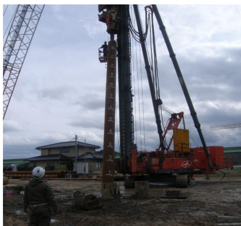
施工写真(杭打ち)
