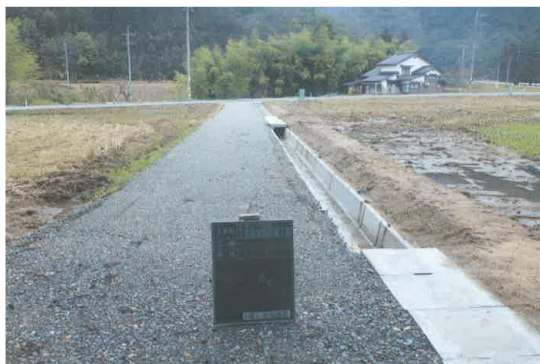
農道水路改修
