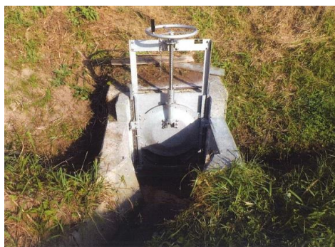
簡易ゲート設置
