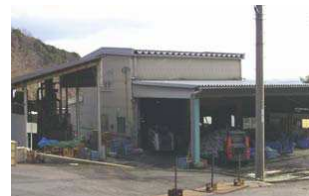
広瀬一般廃棄物最終処分場 不燃物処理施設 埋立終了年度:2021
