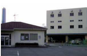
高尾クリーンセンター 粗大ごみ処理施設
