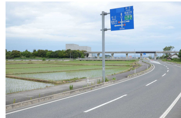
県道切川バイパス（写真奥は安来道路と総合文化ホール）
