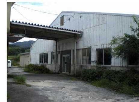
建設予定地 (旧トスカ工場棟跡)
