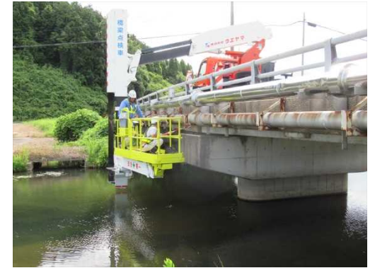
橋梁点検車による点検状況
