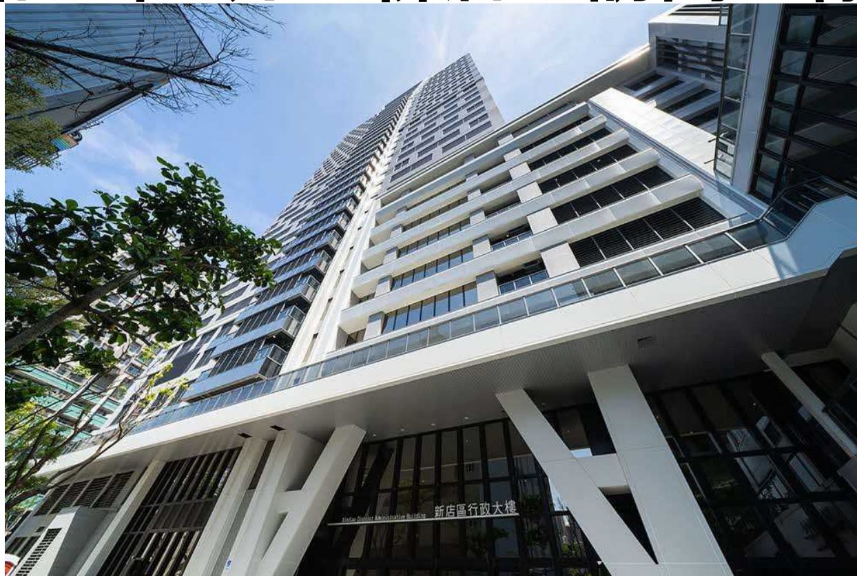
新店区役所が入る「新店区行政ビル」
