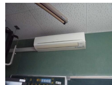
空調設備改修工事
