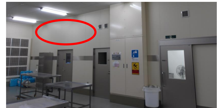
設置予定箇所 (安来市給食センター洗浄室)
