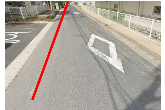
通学路安全対策 (区画線修繕)
