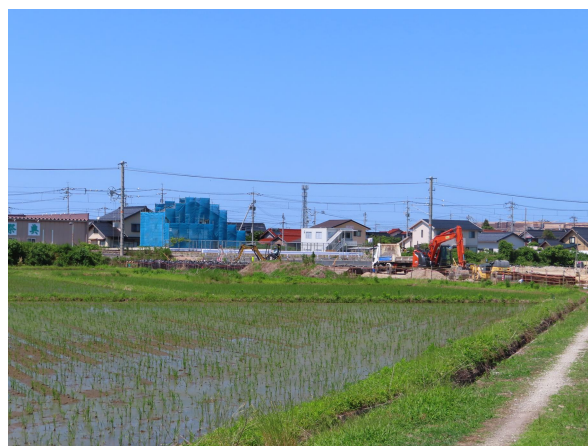
(2) (主) 安来木次線切川2工区 整備状況
