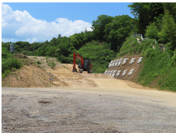
(1) 国道432号 菅原広瀬バイパス 2工区
