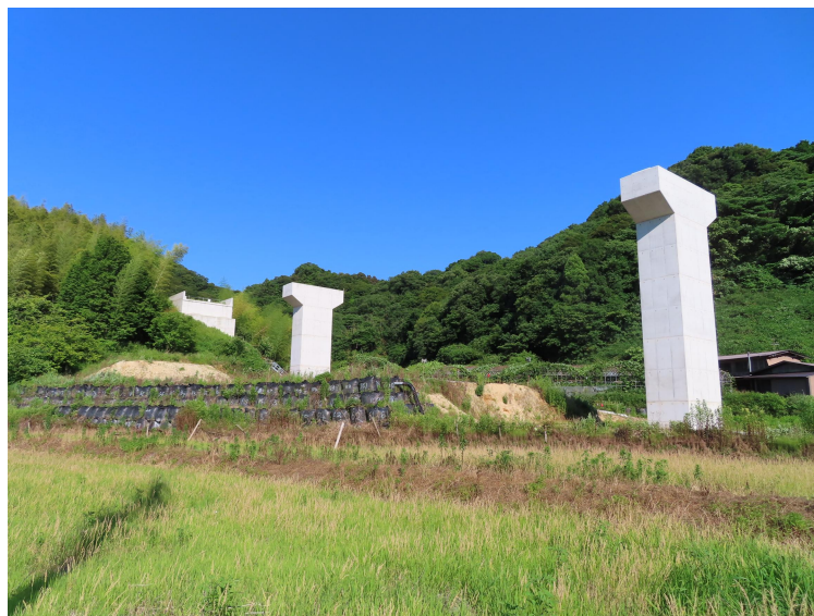
(１) 安来インター線の整備状況
