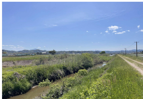
浚渫が必要な河川（吉田川）
