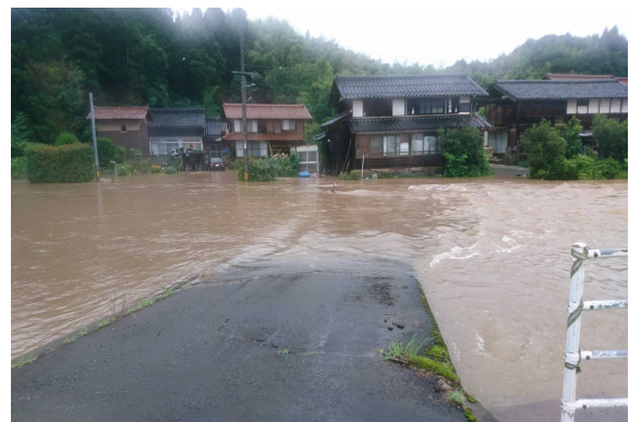
津田平川の氾濫状況（令和3年）
