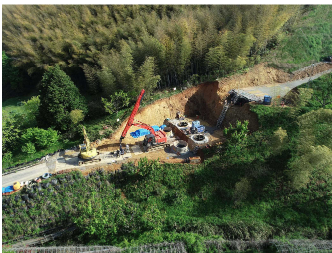
安来インター線工事の様子
