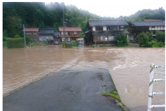
津田平川の氾濫状況（令和3年）
