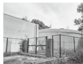
▲社日配水池 (安来町)
