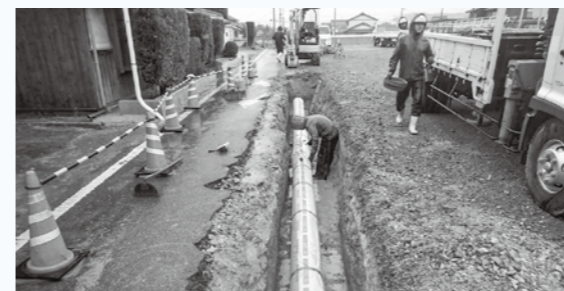
◀配水管工事の様子
