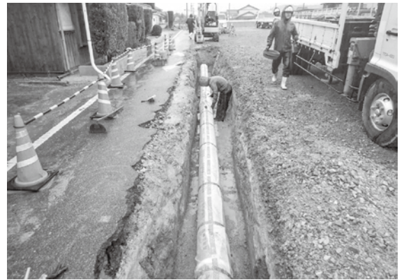
▲水道管の耐震化を進めています。
