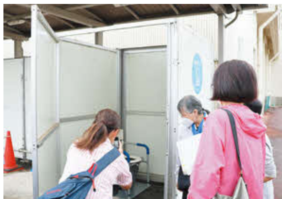
▲災害時には体育館裏側にマンホールトイレ6カ所（うち1カ所は身体障がい者用）を設置します。
