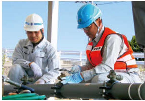
▲配水管から宅内へ給水するための水道管分岐作業を行っています。
