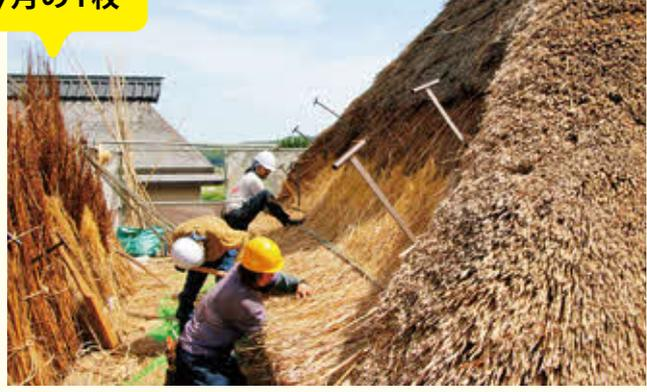
最近では珍しい光景となった茅葺屋根の葺き替え。北側と東側は10年前に葺き替えられており、今回は西側と南側を対象に熊本産のススキを使用。傷みの状態に応じて差し茅（部分的な補修）や全体の葺き替えを行います。 6月18日：出雲織・のき白鳥の里（沢町）
