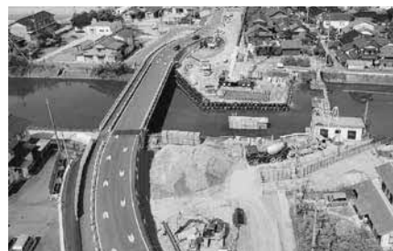
安来港飯島線道路改良事業
