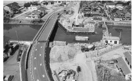
安来港飯島線道路改良事業
