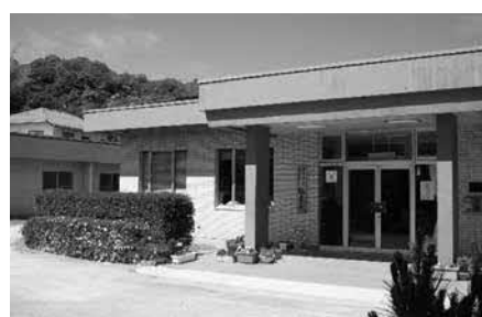
◀ 建築から40年以上が経過し、老朽化が進む鴨来荘。
