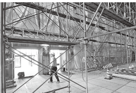
▲工事中の市民体育館。現在、全面に足場が組まれています。
