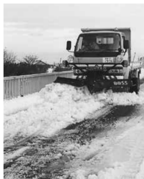
除雪作業の様子
