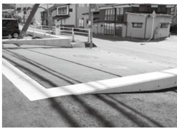
▲安来港に設置した擁壁
