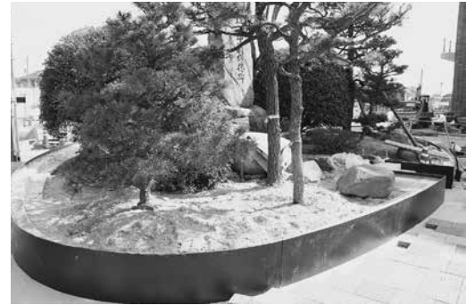
▲植え込みは鋼板で囲われ、来待石のベンチができます。
