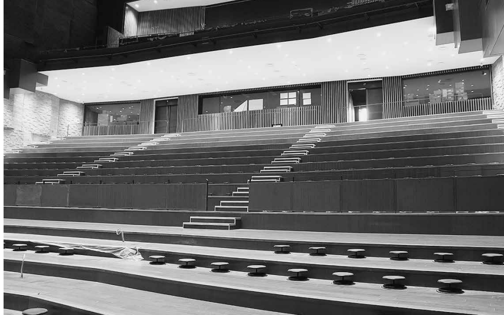
▲客席が未設置の状態の大ホール。1階席は段差が設けられ、ステージが見やすくなっています。板材をふんだんに利用した明るい空間です。
