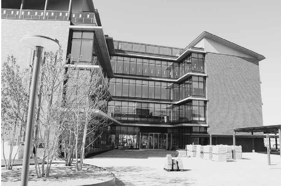
▲北側（国道9号側）から見た新安来庁舎。庁舎周辺は平板舗装で仕上げられています。
