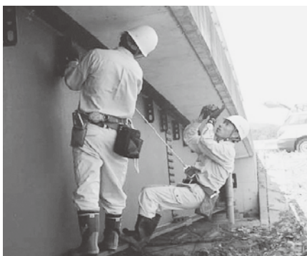
▲橋梁の点検作業
