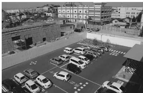
▲安来庁舎では車庫棟と駐車場を整備中です。
