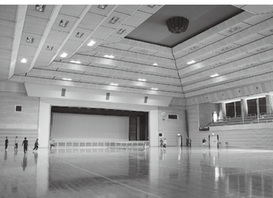
▲法改正により耐震不足となった市民体育館。平成29年度に設計業務、その後、改修を行います。
