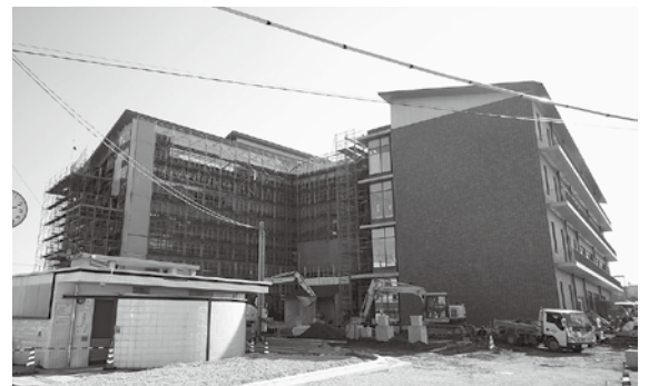
▲7月末に供用を開始する安来庁舎。建設は進み、西棟は姿を現しています。
