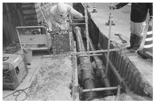
◀老朽化した水道管の更新工事の様子(安来町)。
