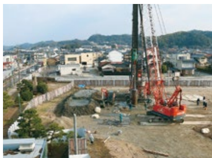
右：くい打ち工事（3月）の様子。最大直径1200mmの杭を設置しています。左：旧市民広場にあった植栽は、新庁舎の外構で活用する計画です。
