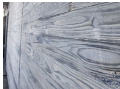
▲外壁には周辺の景観をイメージすることができるようにデザイン。写真の外壁では杉板の型枠を使用し、自然な壁面を演出。
