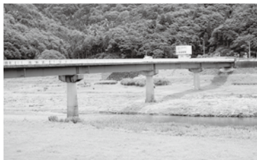
▲補強を終えた太平寺橋
