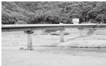
▲補強を終えた太平寺橋
