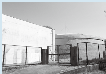
▲社日配水池（安来町）。
