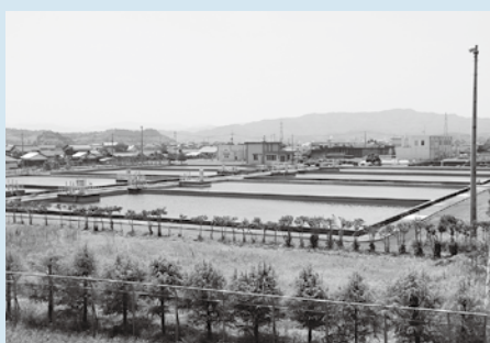
▲島根県企業局（上坂田町）の緩速ろ過池。
