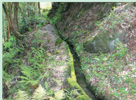
急斜面に掘られている約400メートル ほどの長さの空田井手
