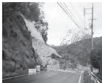
県道安来木次線で発生した土砂災害（昨年12月）
