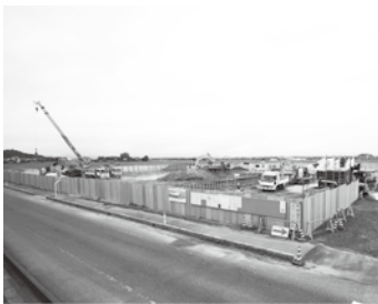
建設が進む給食センター。
