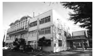
▲安来庁舎。今後、平成28年度のしゅん工に向け建築工事に着手します。
