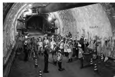
▲整備が進む安農広域農道。平成27年11月に全線が開通する予定です。
