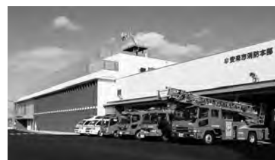
▲新築した消防新庁舎。
