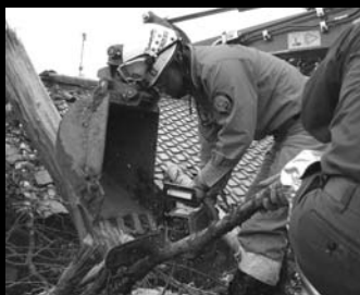
▲大木はチェーンソーで細かくして運搬
