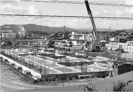
整備の進む消防新庁舎
