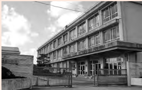
▲築後28年の能義小学校。老朽化が進む校舎の教育環境改善を図るため、長寿延命化改修を実施します。
