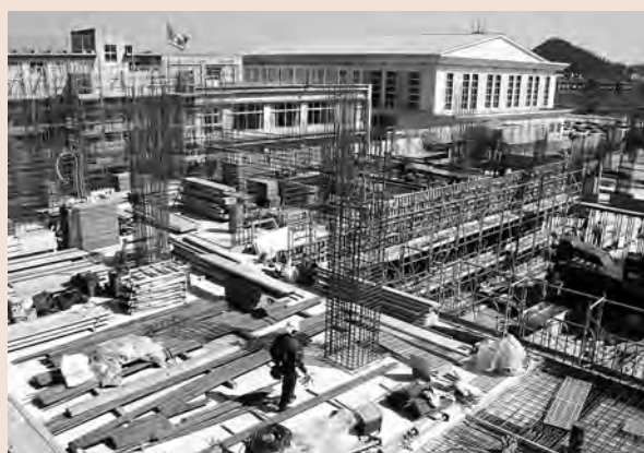
▲整備の進む第一中学校校舎改築工事。 平成25年度の供用開始を目指します。
