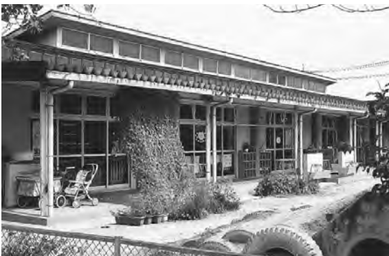
耐震補強工事をする城谷保育所
