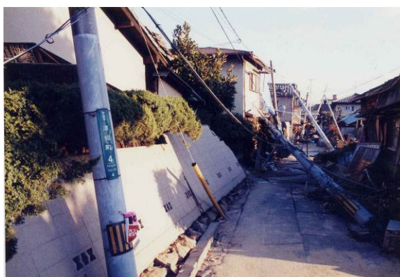
図 5-3 阪神淡路大震災における転倒被害状況 (阪神・淡路大震災記念 人と未来防災センター提供資料)
