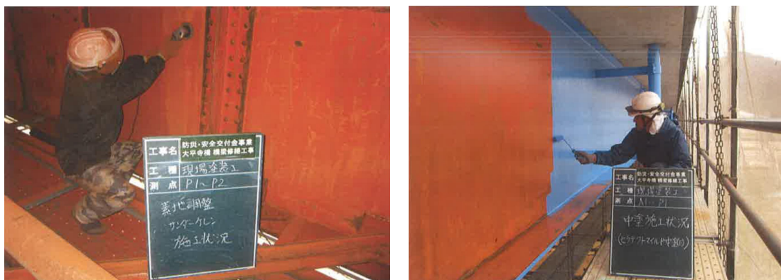
写真 4-1 再塗装工実施状況
