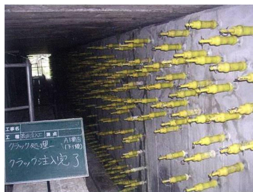
写真 4-2 ひび割れ注入状況
