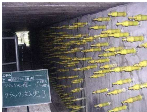
写真 4-2 ひび割れ注入状況
