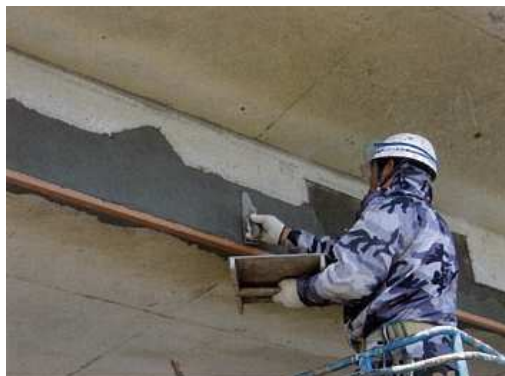
写真 4-3 断面修復状況
