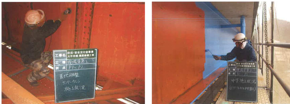
写真 4-1 再塗装工実施状況
