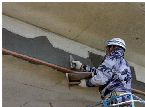
写真 4-3 断面修復状況
