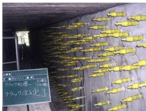
写真 4-2 ひび割れ注入状況
