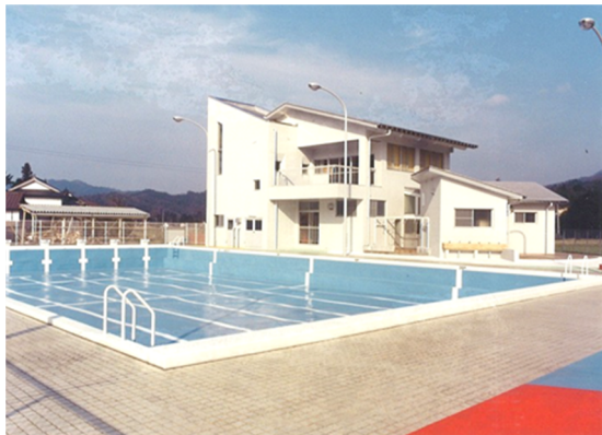
▲竣工当時のプールと管理棟
