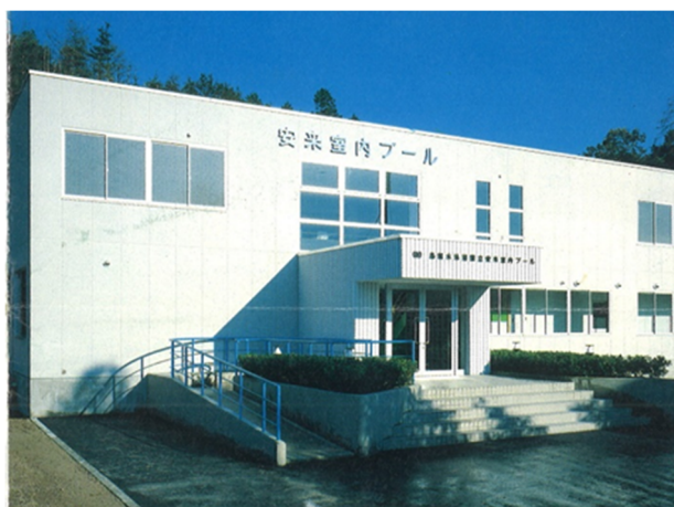
▲完成当時の安来室内プール(外観)
