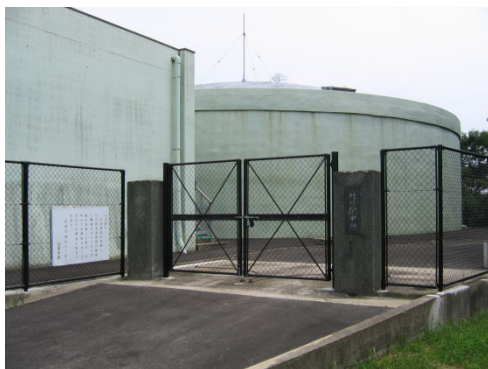
社日配水池（安来市）
