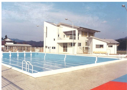
▲竣工当時のプールと管理棟
